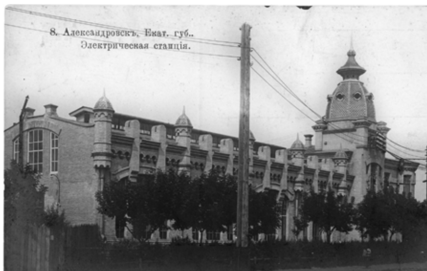
Электрическая станция г. Александровска. Фото 1912 г.
