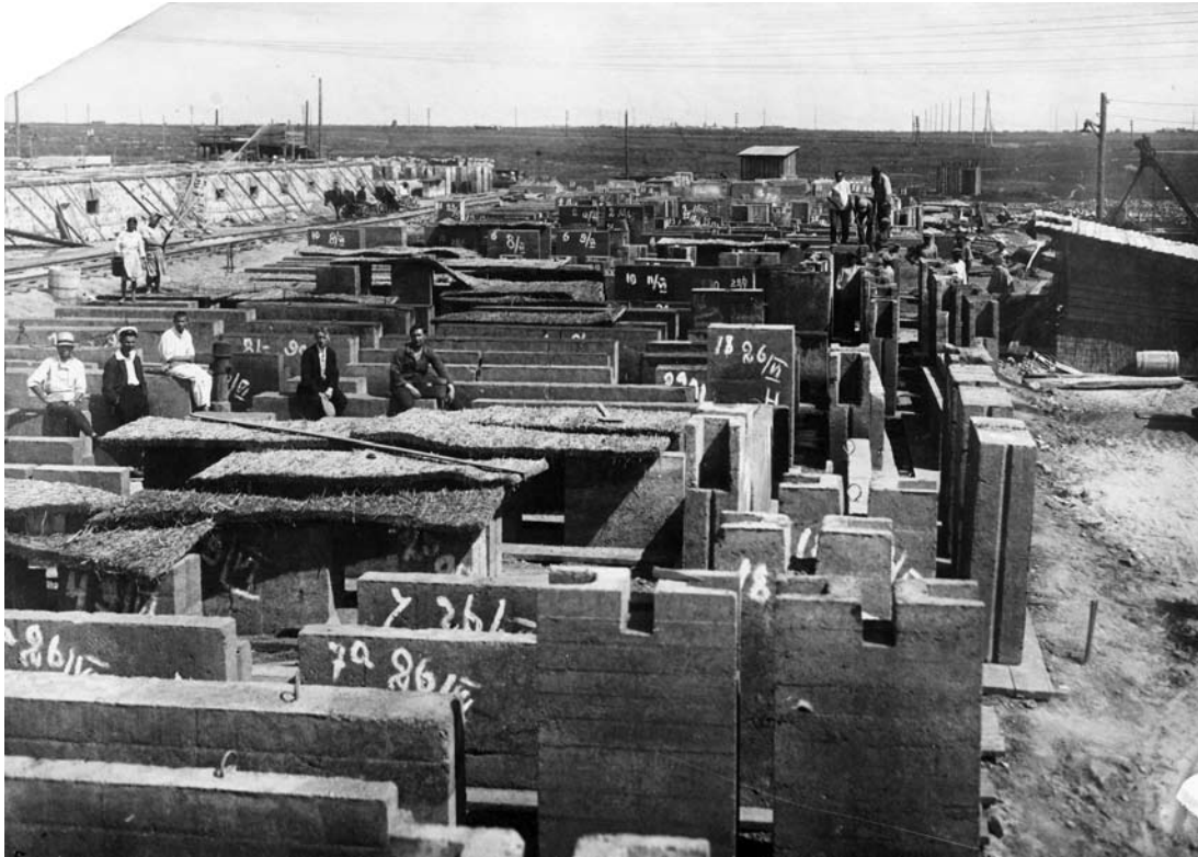
Рис. 7. Крупноблочное жилое строительство на Шестом поселке, 1932 г. Фото из личной коллекции В. А. Гущи
